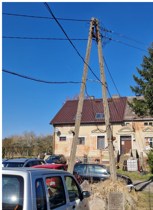
Foto nr 2 – istniejący słup nr 11/II linii napowietrznej AsXSn 4x25mm 2
