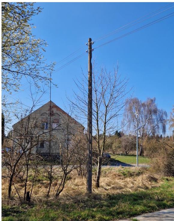
Foto nr 1 – istniejący słup nr 10/II linii napowietrznej AsXSn 4x25mm 2
